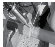
⑤ 接合部の塩ビ溶接
