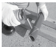
② FRP層の加熱剥離
