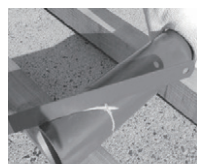
① FRP層の切り込み
