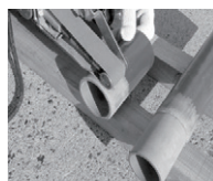
③ FRP層の表面処理
