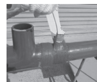
⑥ 接合部のFRP補強
